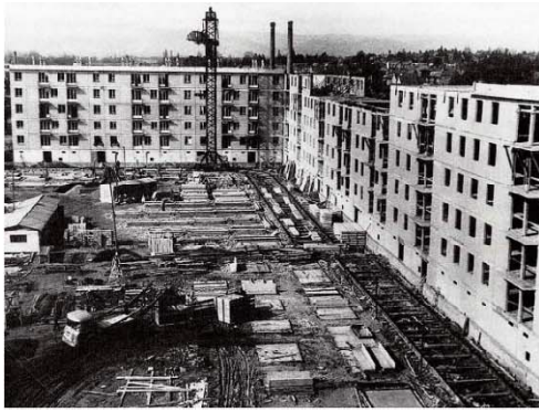
図 2 1963 年フランス PCa 住宅施工現場 図 3 1960 年代末 PCa 構法 [3] 図 4 フィンランド BES 工業標準システム [1]
