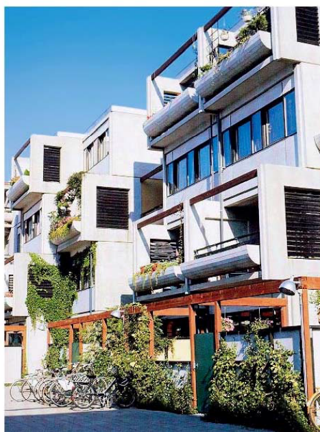
図 5 低層 PCa 住宅及び工業化部品組合せ例(デンマーク)
