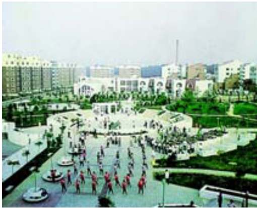
図 10 河北省石家庄联盟団地の普及型住宅 実験棟
