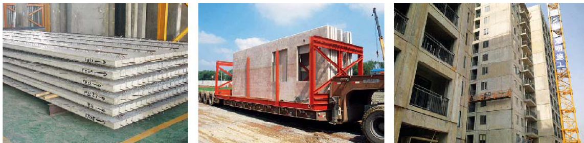
図13 左から:重ねスラブ・サイディングパネル・長沙花漾年華の施工現場
