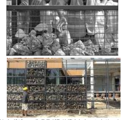
コンクリートガラを利用したガビオンウォール構築の論理 作業員が取り壊されたコンクリートガラをガビオンウォールに充填
