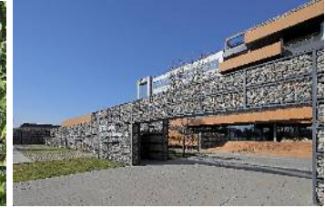
コンクリートガラを利用したガビオンウォール構築の論理 作業員が取り壊されたコンクリートガラをガビオンウォールに充填
