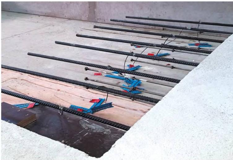
柱をコンクリートスラブに固定する、あるいはバルコニーをファサードに取り付ける場合、コンクリート内の化学剤によるシーリングが必要である。火災時のこうした接続挙動を説明するために、CSTBは、試験評価方法を開発した。4年間の研究開発の産物として、2015年に欧州全土の承認を取得した。現在、北米での使用に向け提案中。ICC評価サービスとの協働
