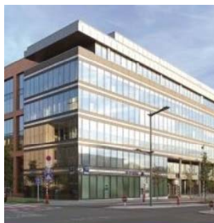
既存の非住宅建築
