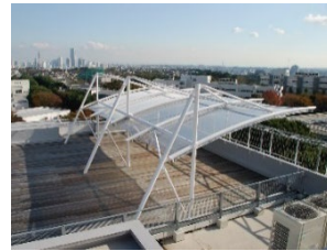
図1 鋼管トラス構造物
