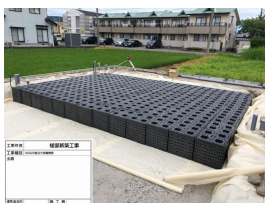
全面置換施工写真
